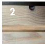
Cette singularité trouve son origine au profi lage, par l'éclat d'un nœud cerné ou mort situé sur le chant. Avec un diamètre maxi autorisé de 15mm, le recouvrement avec la lame inférieure est suffisant pour assurer l'étanchéité du bardage.
