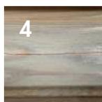
Elles se présentent comme des fentes de surfaces étroites orientées suivant la longueur de la lame. Elles apparaissent principalement lors du séchage ou par temps sec. Elles se referment partiellement en période humide ou pluvieuse.
