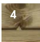
Cette singularité trouve son origine au profilage, par l'éclat d'un nœud cerné ou mort situé sur le chant. Avec un diamètre maxi autorisé de 15mm, le recouvrement avec la lame inférieure est suffisant pour assurer l'étanchéité du bardage.
